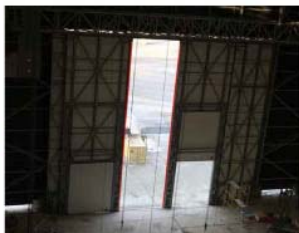
Установка подъемных секционных ворот в подвижную створку
